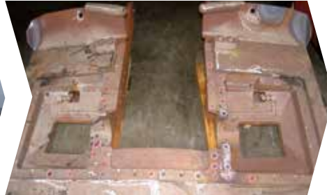
BESTANDSAUFNAHME REPARATUR LADETISSCH
