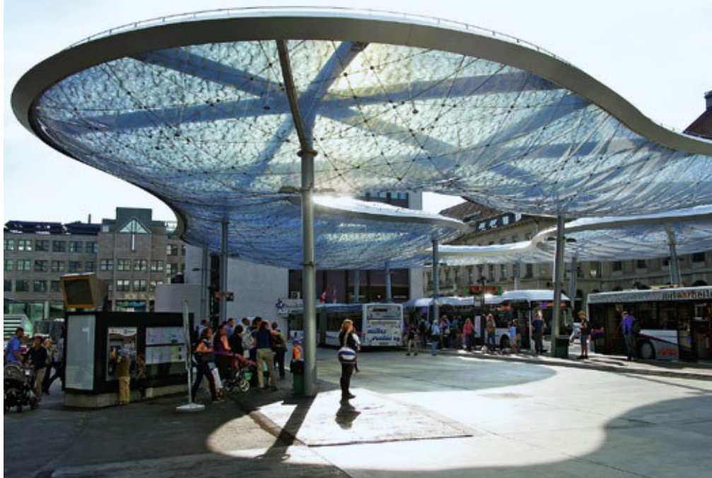
Dauerhaft und wartungsfrei: Die feuerverzinkte und anschließend beschichtete Stahlkonstruktion.
