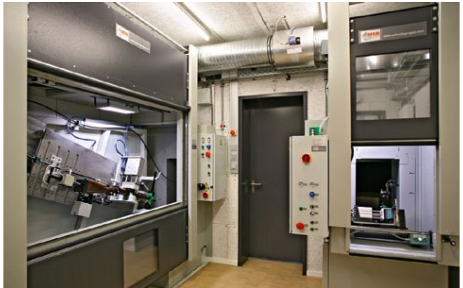
Innerhalb eines Jahres hat das Bischofsheimer Unternehmen MSB Maschinenbau in enger Zusammenarbeit mit den Experten vom Staatlichen Beschussamt Mellrichstadt hochmoderne und innovative Waffenprüfstände für Lang- (li) und Kurzwaffen (re) entwickelt. (Foto: Schmitt Werke/Kerstin Junker)
