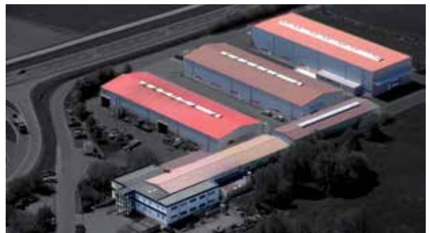
Schmittwerke 2, Industrial area Bischofsheim
